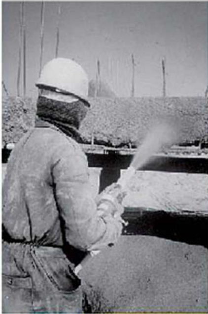
Fotografia 2.1 - Concreto projetado via úmida
