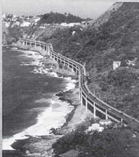
Elevado do Joá RJ - Recuperação e Reforço Estrutural
