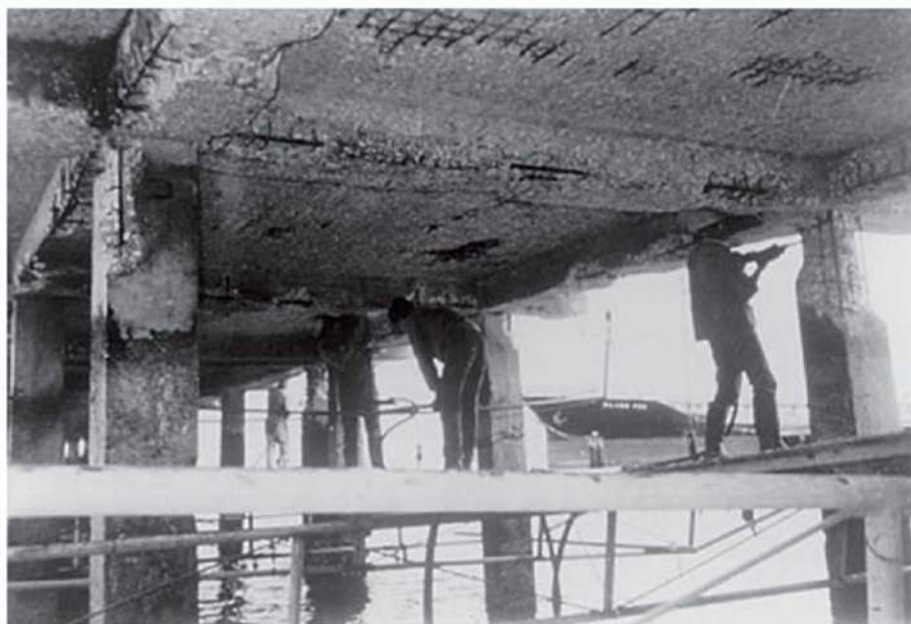
Fotografia 3.3 - Remoção de concreto por corte
