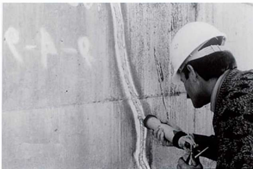
Fotografia 3.5 - Injeção de fissura
