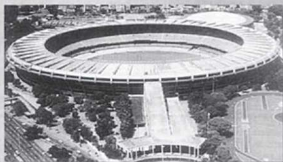
Maracanã RJ - Recuperação e Reforma
