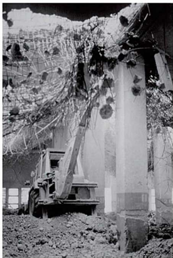
Fotografia 3.4 - Demolição de concreto
