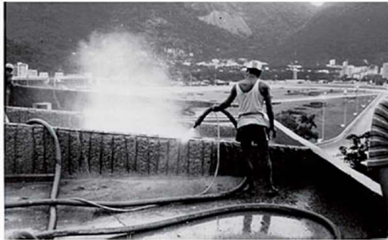
Fotografia 3.1 - Aplicação de jatos de água para lavagem de superfície de concreto
