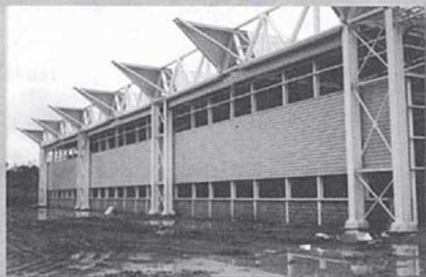
Valeo Térmico LTDA SP - Projeto, gerenciamento e construção em contrato Turn-Key
