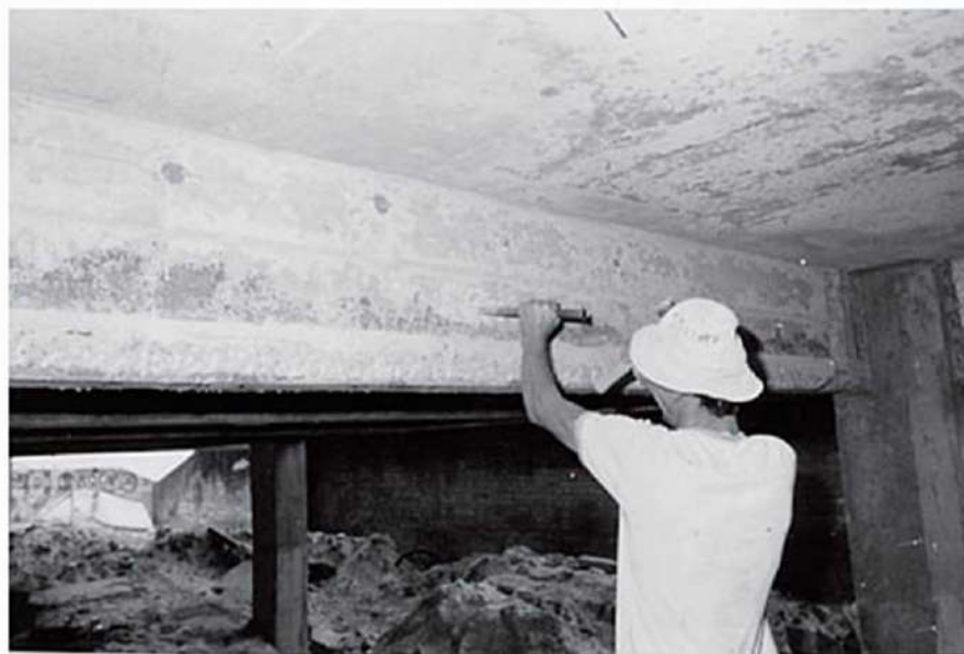
Fotografia 3.2 - Apicoamento manual da superfície de concreto
